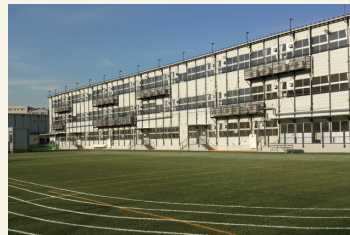
▲千寿小学校仮設校舎
