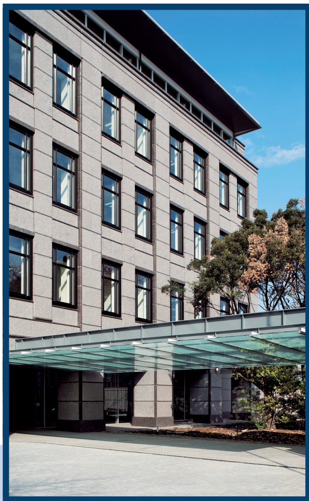
(本社ビル外観)
